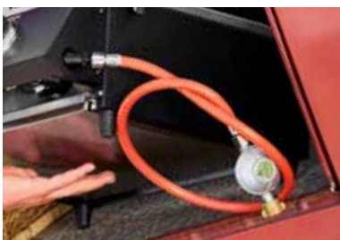
Gasdruckregler mit Schlauchbruchsicherung
